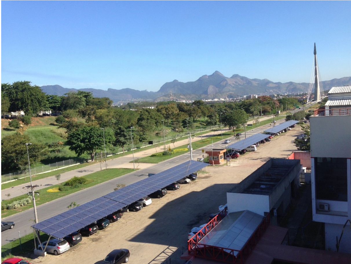
Sistema fotovoltaico UFRJ • Créditos: Fundo Verde
